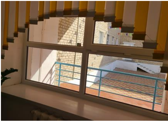
草の根資金により改修された窓
