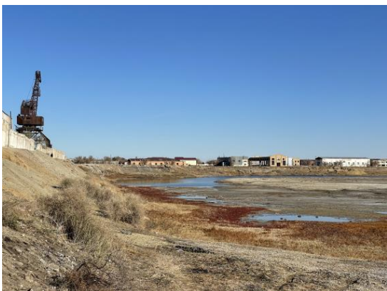
Остатки портовых сооружений в городе Арал
