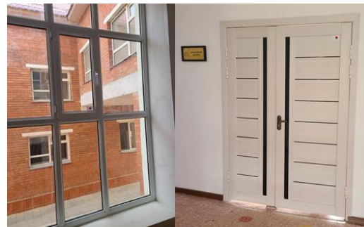
Отремонтированные окна и двери
