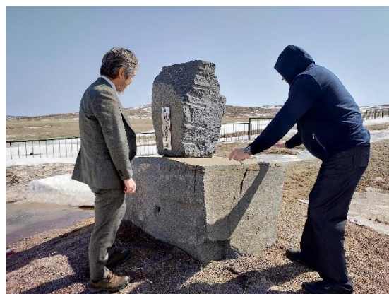
地盤全体が不安定化し倒壊の危険
