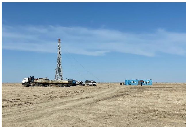
Бурение скважин при грунтовых водах USAID
