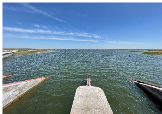
Вид на Малый Арал с северной стороны плотины
