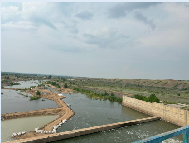
アクトベ貯水池の放水地点
