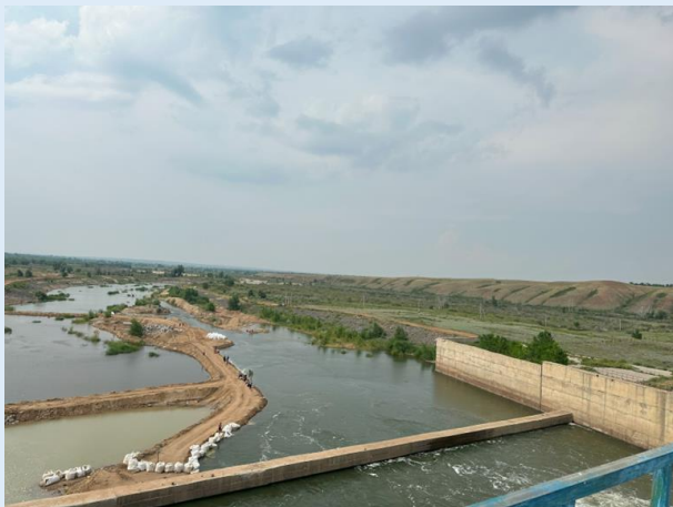
Пункт водосброса Актюбинского вдхр
